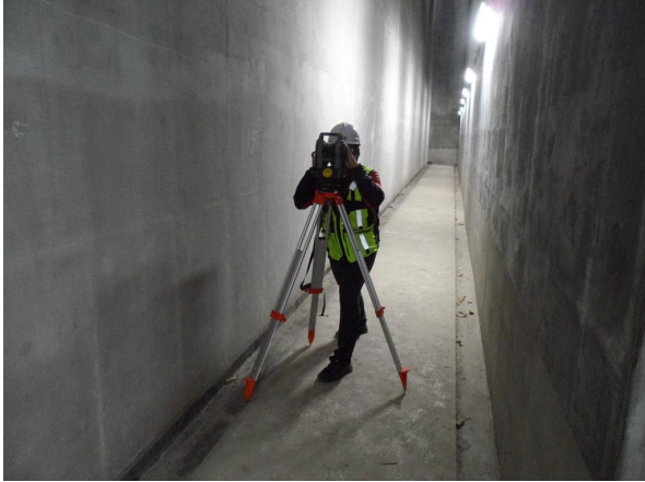
광파기를 이용한 측량 작업
