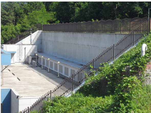
옹벽 상단 전경
