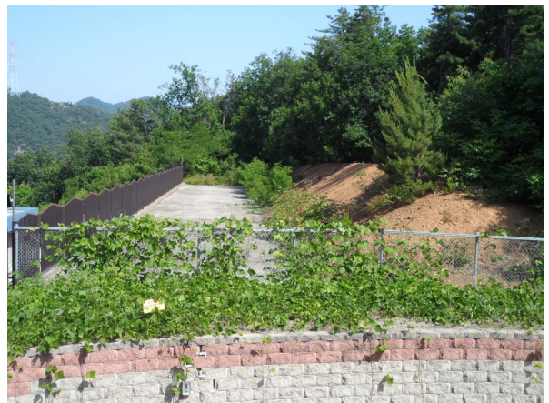
상부 성토부 전경
